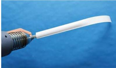
ヒシチューブを支柱寸法よりも50mm程度長めにカットして支柱に被せます。
